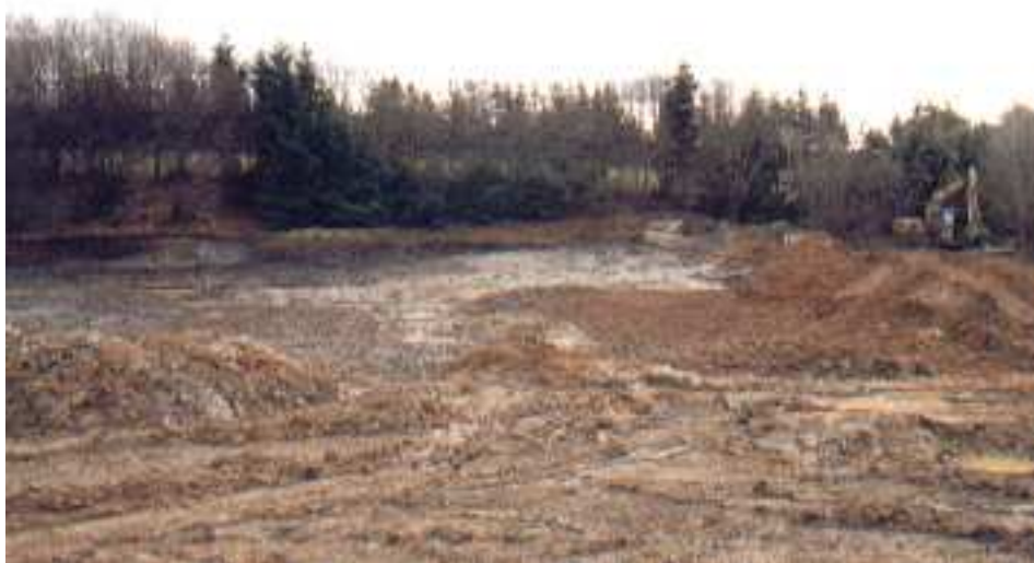
Rybník nad koupalištěm při stavbě
