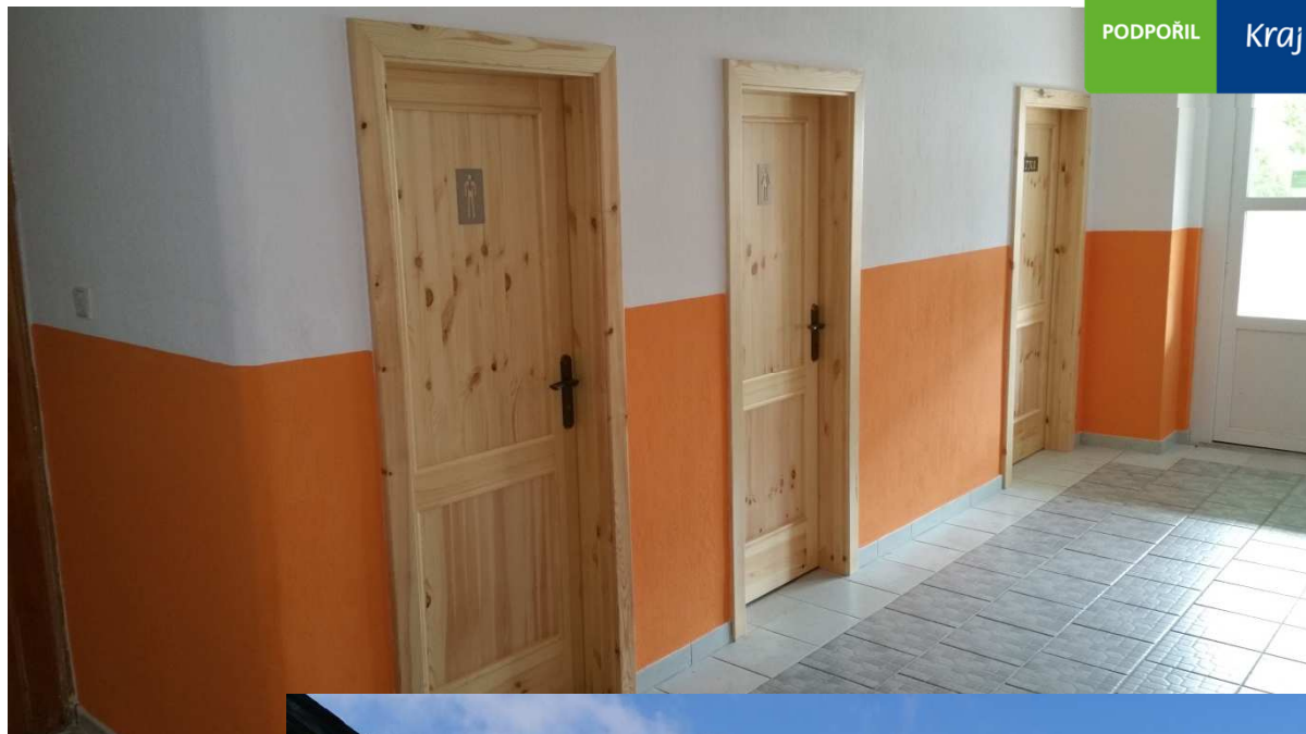
Oprava sociálního zařízení v KD
