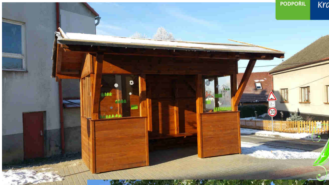
Opravená zastávka BUS
