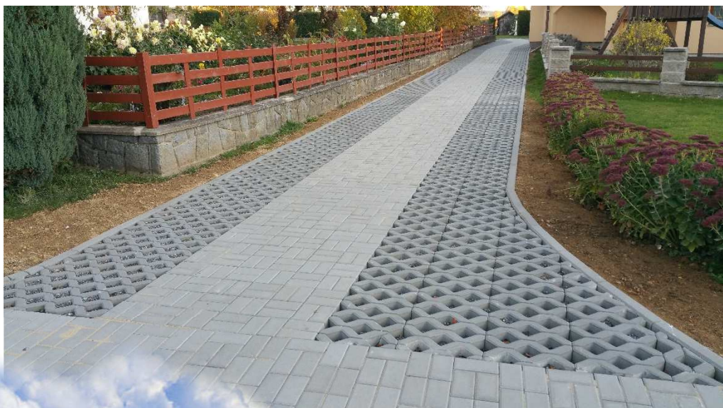
Zpevněná komunikace u č.p. 30
